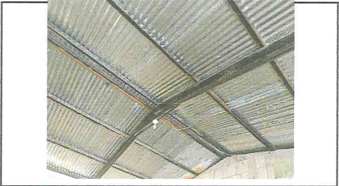
Foto 4: Sustitucion de lamina
